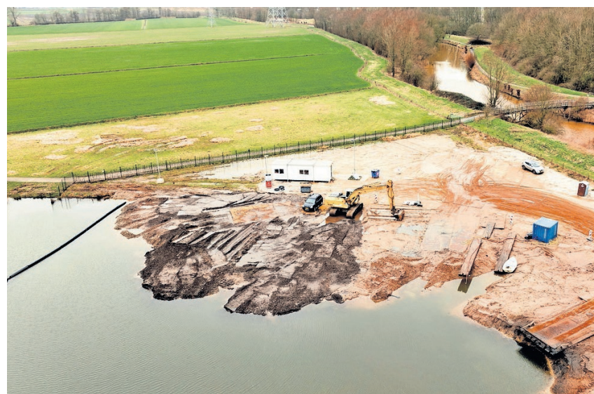
▲ Werkzaamheden bij de Plas van Caron, met rechtsboven de beek de Donge. FOTO LUUK DONDERWINKEL/K3
